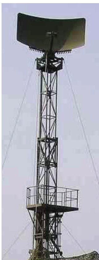
Vindkraftverk kan störa försvarets radarövervakning av de svenska kusterna. Foto: Magnus Bohman, Försvarets Bildbyrå.
