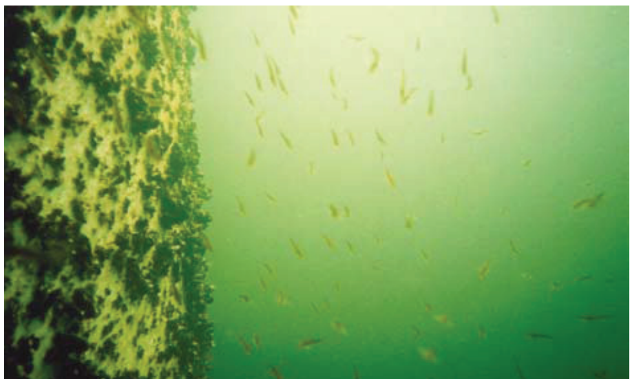
Vindkraftsverkets betongfundament inklätt i blåmusslor och simmande sjustrålig smörbult. Foto: Dan Wilhelmsson.
